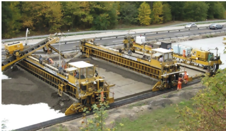
Dvojvrstvé ukládání betonu finišery Heilit+Woerner s klznými bočnicemi Zdroj: http://grossprojekte.strabag.de/
