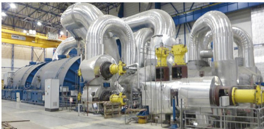
Dynamická zkouška základu turbosoustrojí
