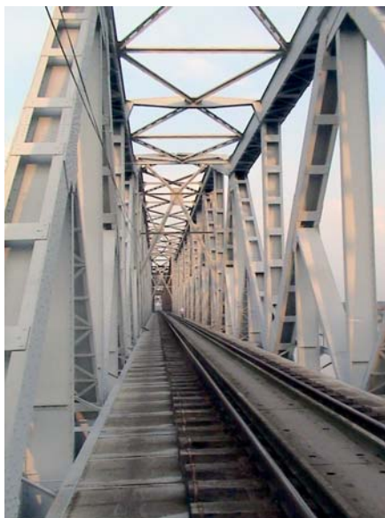
Vstupní železniční most přes řeku Sávu prošel z důvodu vzniku zón rekonstrukcí. (foto autor)
