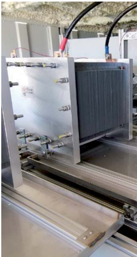
Pohled do útrob systému vanadové redoxní průtočné baterie se třemi 5kW svazky. Zdroj: Pinflow
