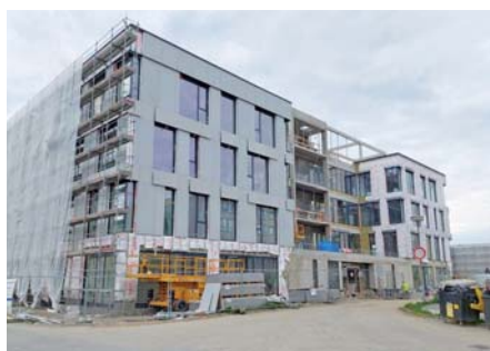
Fotografie stavby (květen 2023), VTP UP
