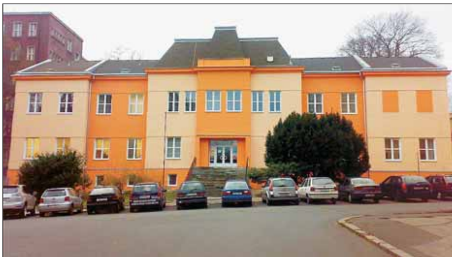
Budova nově vzniklého VTP po celkové rekonstrukci
